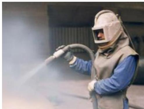
Příprava podkladu tryskáním vodním paprskem.
