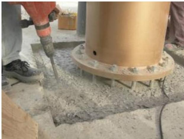
Mechanická příprava podkladu pomocí ručního nářadí.
