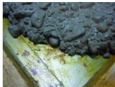
Uložte beton do bednění ošetřeného retardačním (zpomalujícím) prostředkem.
