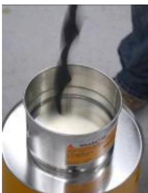
Míchejte oba komponenty pomocí nízkootáčkového elektrického míchadla (300 - 400 ot./min.).
