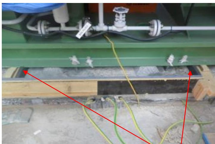
Předem instalované dilatační/řízené spáry
