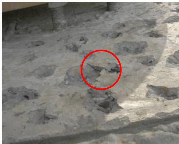
Po mechanické přípravě ručním nářadím může mít podklad sníženou přídržnost, především z důvodu možných vzniklých prasklin a mikrotrhlin (viz červený kroužek).
