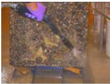
...a vrstvy retardačního (zomalujícího) prostředku a nevytvrzeného betonu jsou zcela odstraněny...
