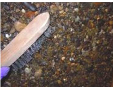
...a následně ocelovým kartáčem pro důkladné odstranění volných nebo slabě držících částic.
